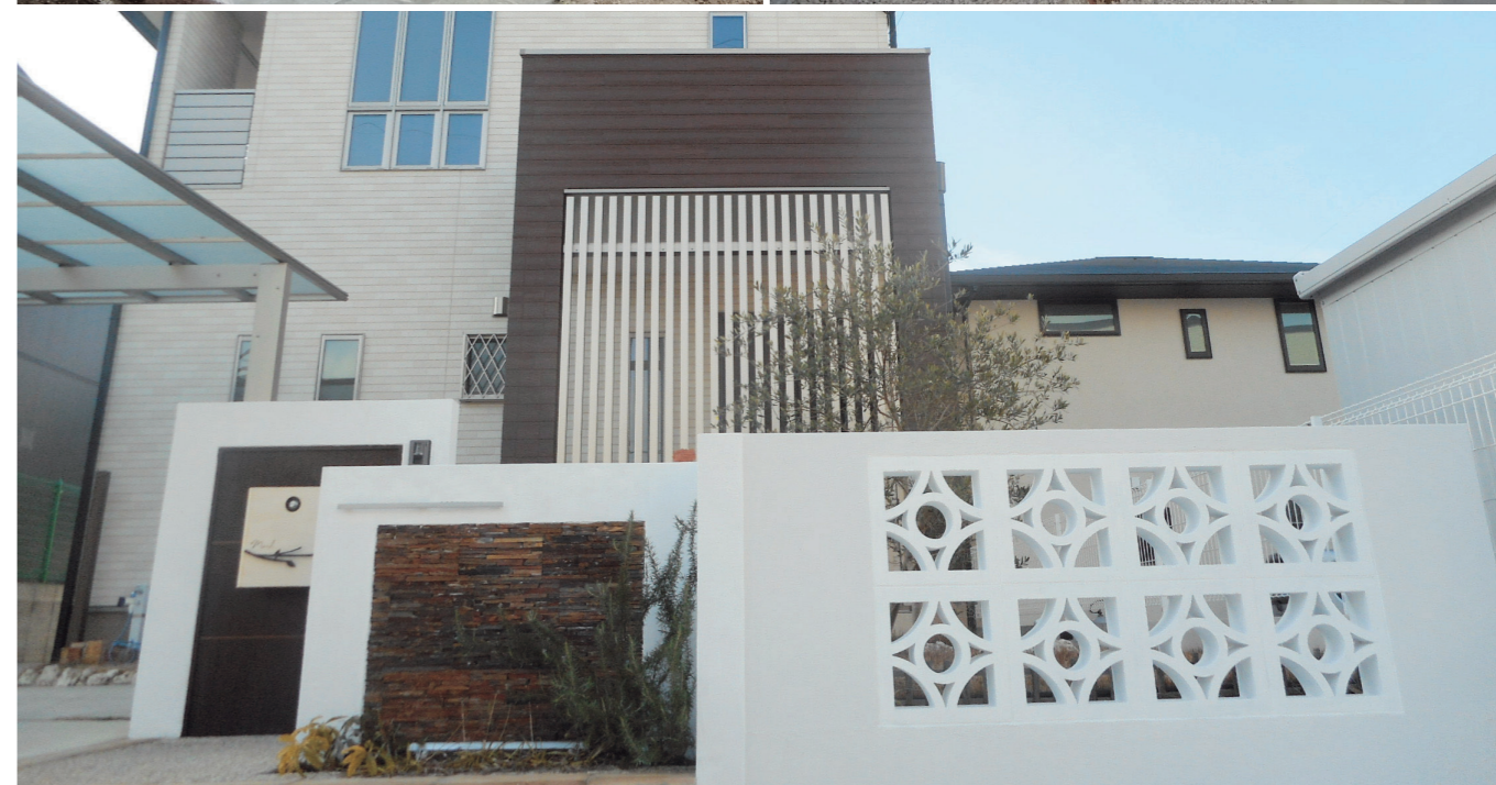
※写真の製品は、現場にて塗装しています。
