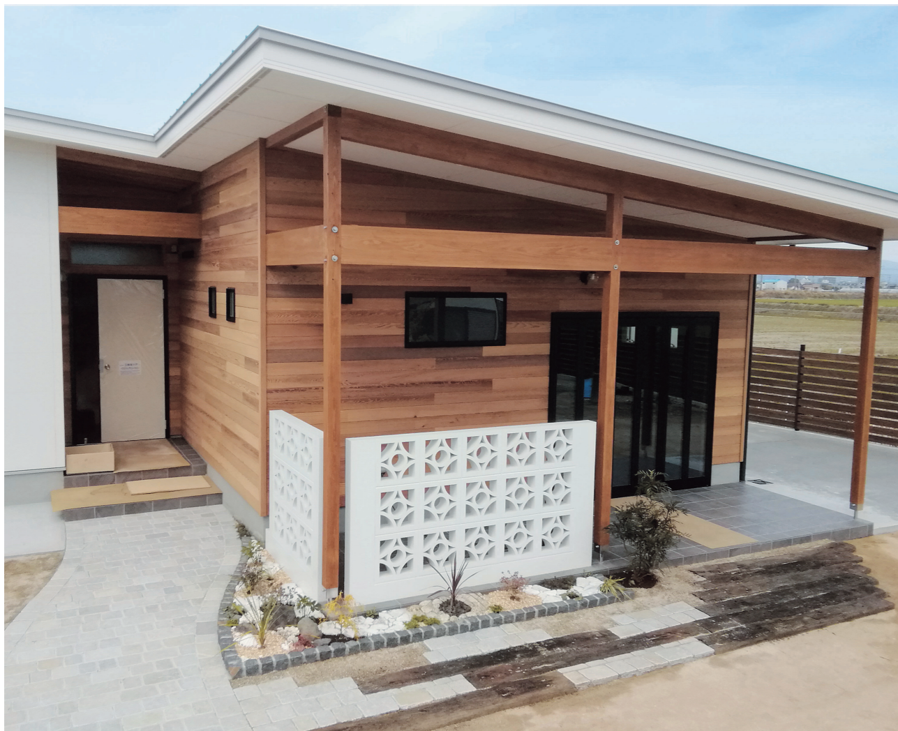
※写真の製品は、現場にて塗装しています。
