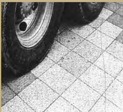
供用2年経過・L 交通相当 (砕石・透水性As安定処理路盤)
